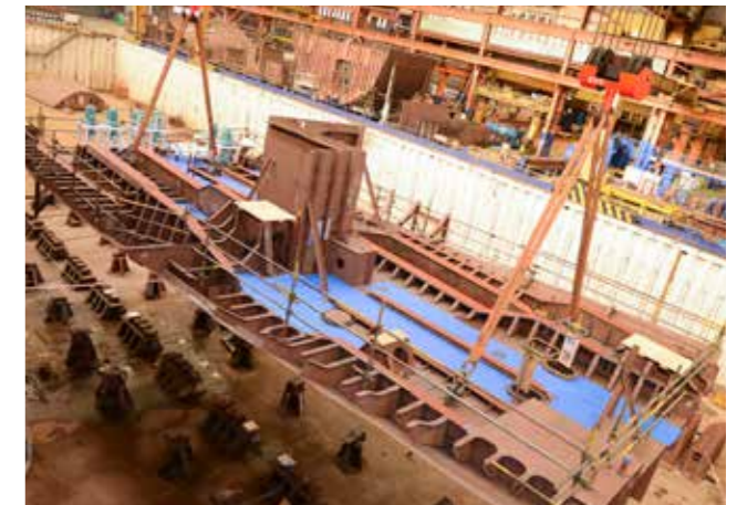
Quille posée sur Lé George Bernard Shaw, quatrième patrouilleur océanique avec système de navigation par inertie
